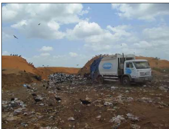
Foto 21. Vala de disposição de RSU, Aterro Controlado de Resíduos Sólidos, Araguaína/TO.
